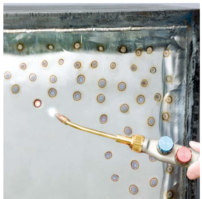
Bild 4.34 Flammrichten eines Blechfeldes
