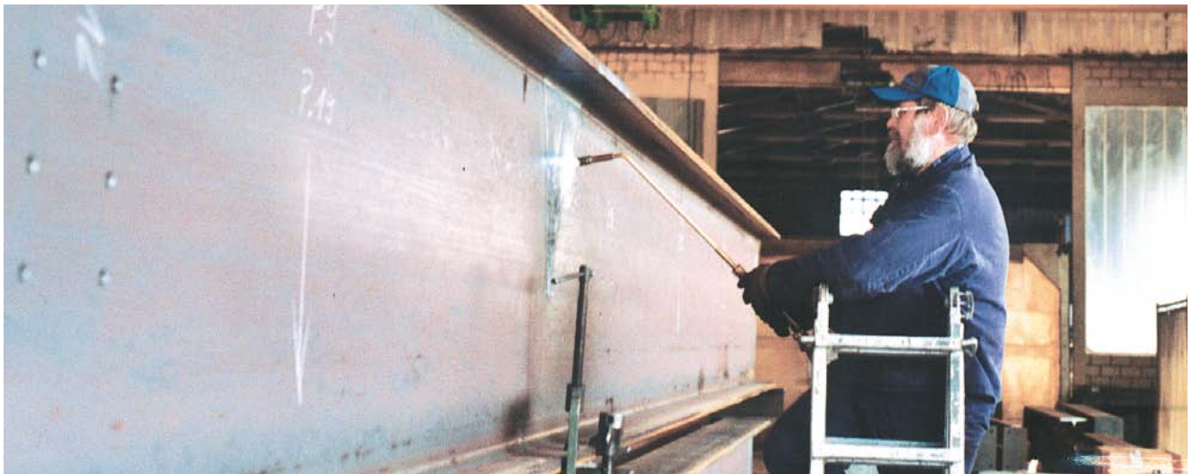
Bild 4.28 Flammrichten an einem Doppel-T-Träger
