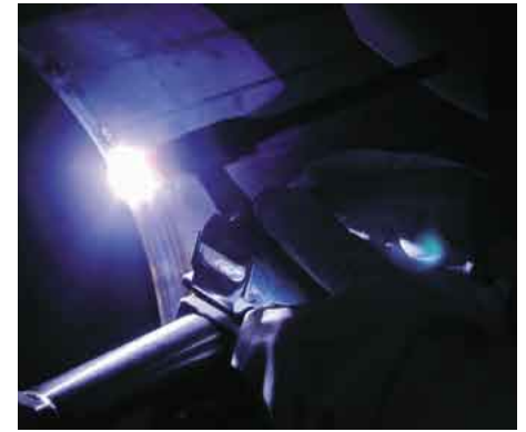
Schweißen unter Formiergasschutz
