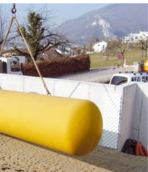
Installation d'un réservoir de 6,4 m 3 pour le chauffage, l'eau chaude et la cheminée
