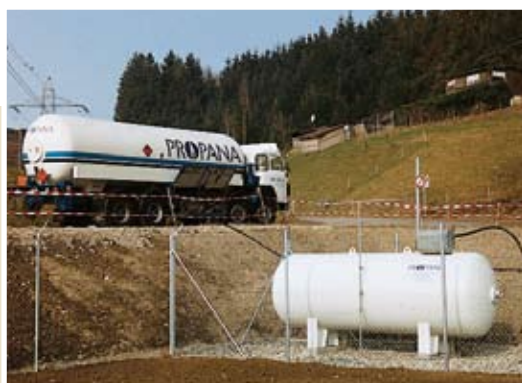
Remplissage d'un réservoir aérien
