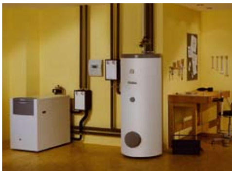
Chaudière pour la préparation d'eau chaude
