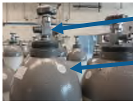
CO 2 -Steigrohrflaschen (mit Steig- oder Tauchrohr)
